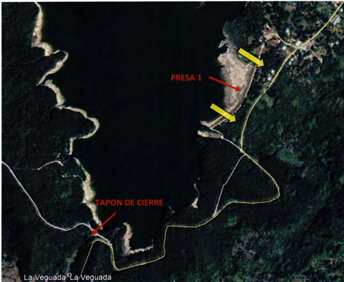
Foto N°1 Localización de la Presa 1 La Yeguada y puntos de colapso
