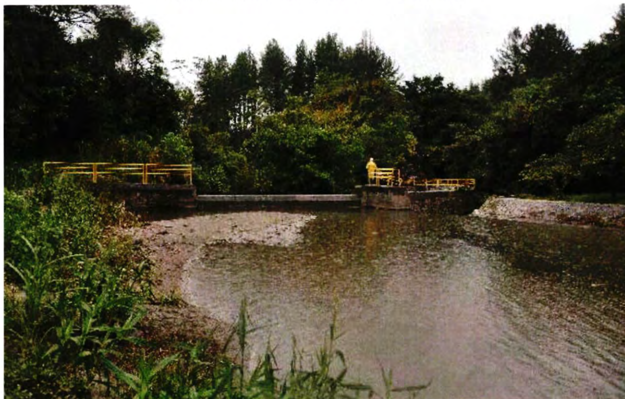
Foto N°2 Embalse de la presa de desvío San Juan
