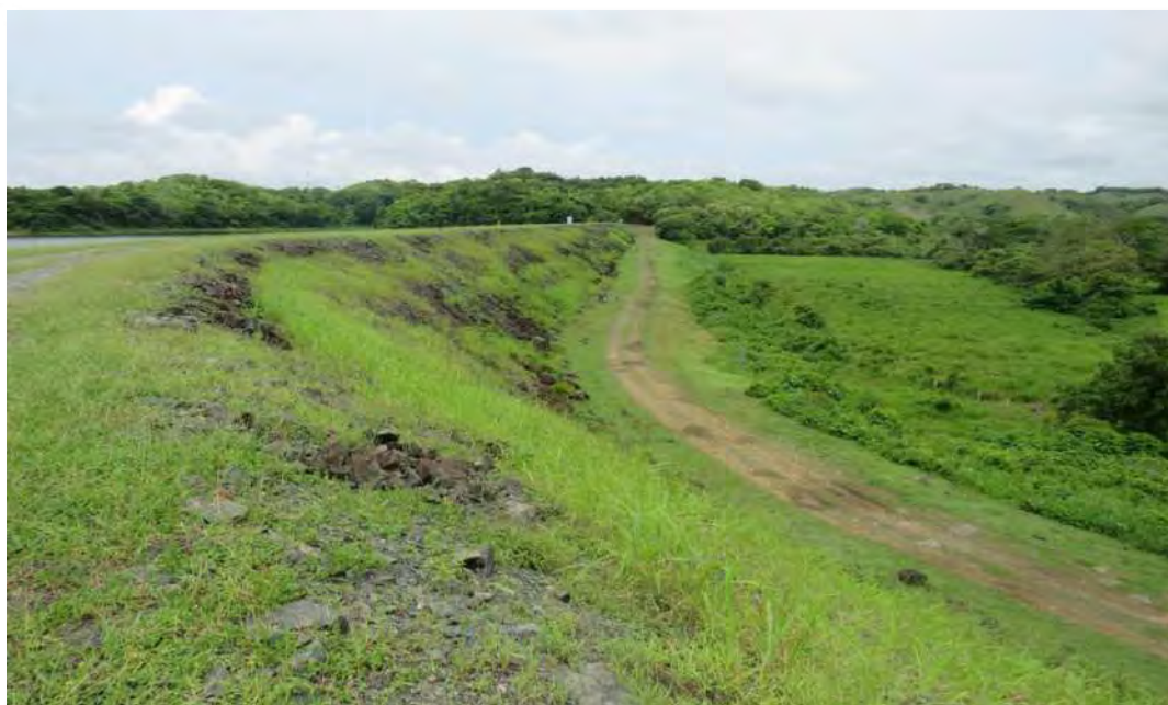
Figura 2.5. Fotografía de la Presa Viejo Pedro desde Estribo Derecho
