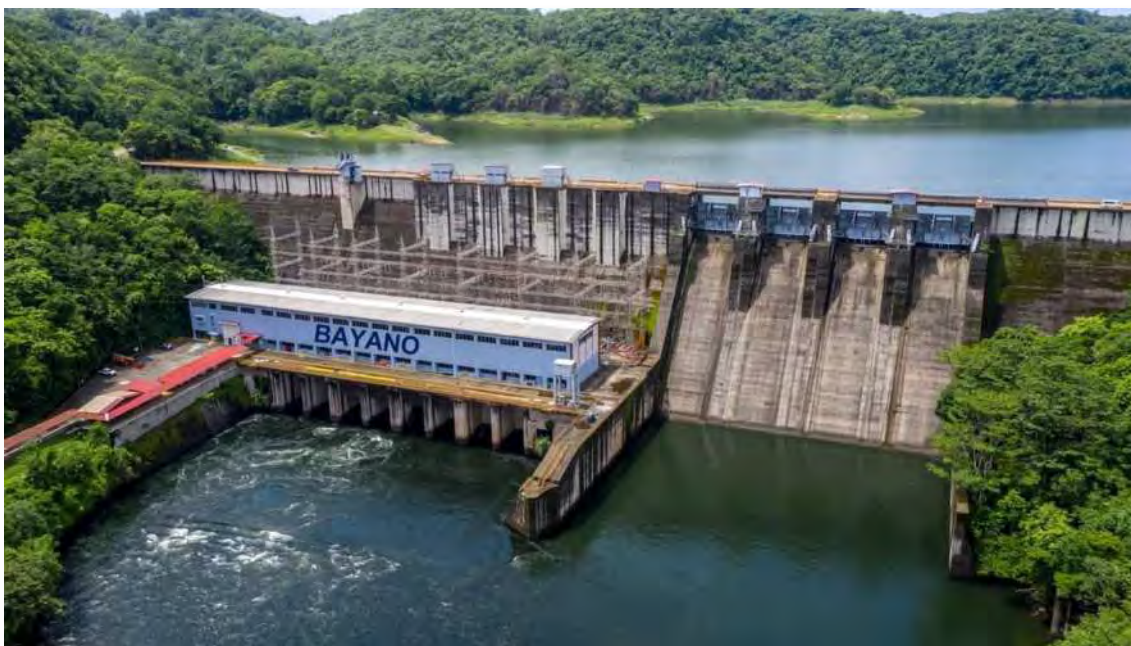
Figura 2.3.- Fotografía y Vista General de la Presa desde Aguas Abajo.
