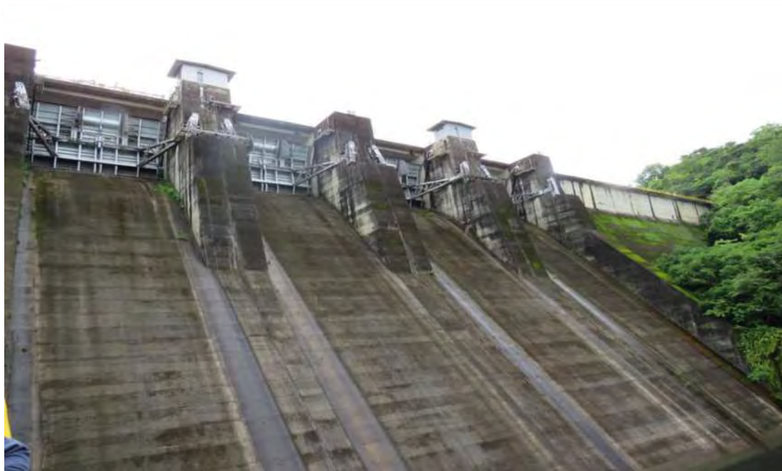
Figura 2.4.- Fotografía del Aliviadero desde Aguas Abajo
