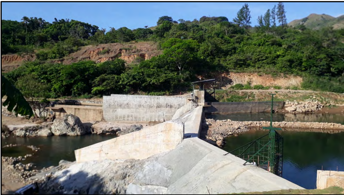
Foto 2. Imagen de la presa de la CH El Fraile, obsérvese el vertedor central libre, con su modificación en la margen izquierda que extiende la longitud de vertedor libre.
