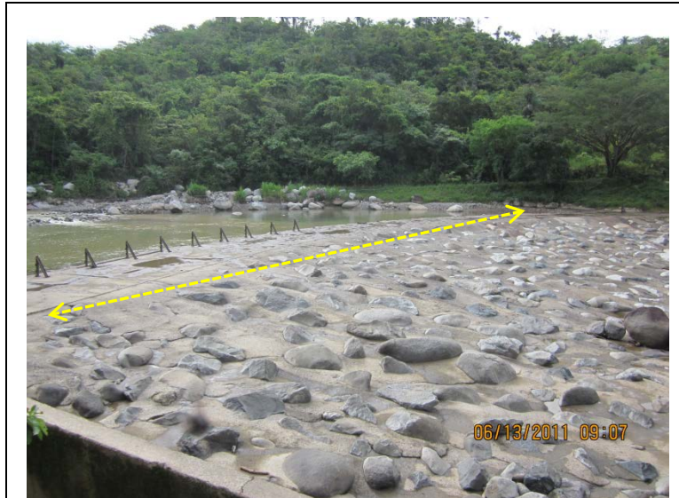
Figura 1 Vista de presa derivadora sobre el río Los Valles
