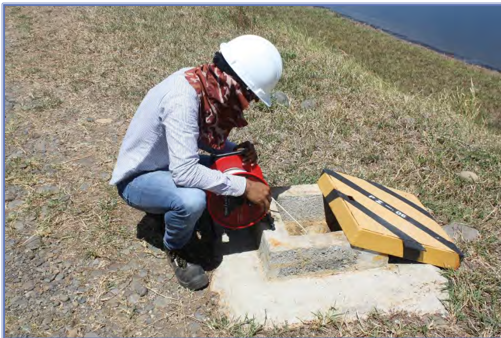
Figura N° 16: Medición de piezómetros en el Canal de aducción CH Prudencia.
