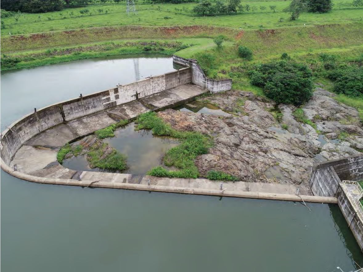
Figura N° 7: Descarga del río Papayal y Cochea en el vertedero libre. Fuente: Alternegy, S.A.
