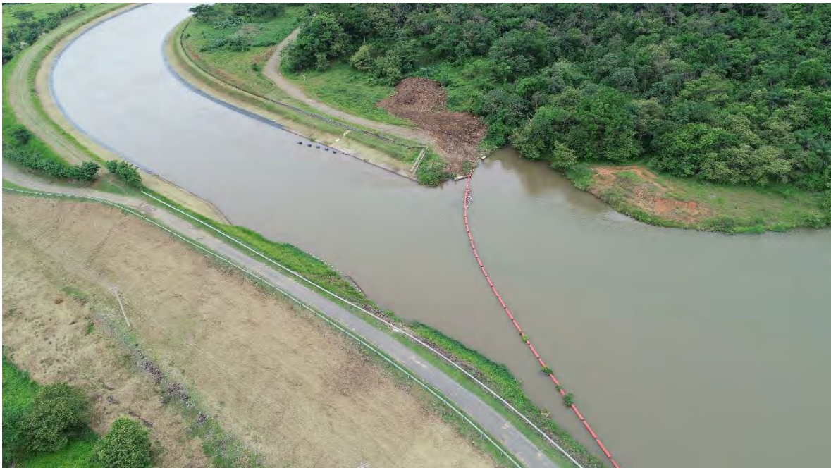
Figura N° 8. Canal de aducción hacia la Central Hidroeléctrica Prudencia y su barrera de contención. Fuente: Alternegy, S.A.
