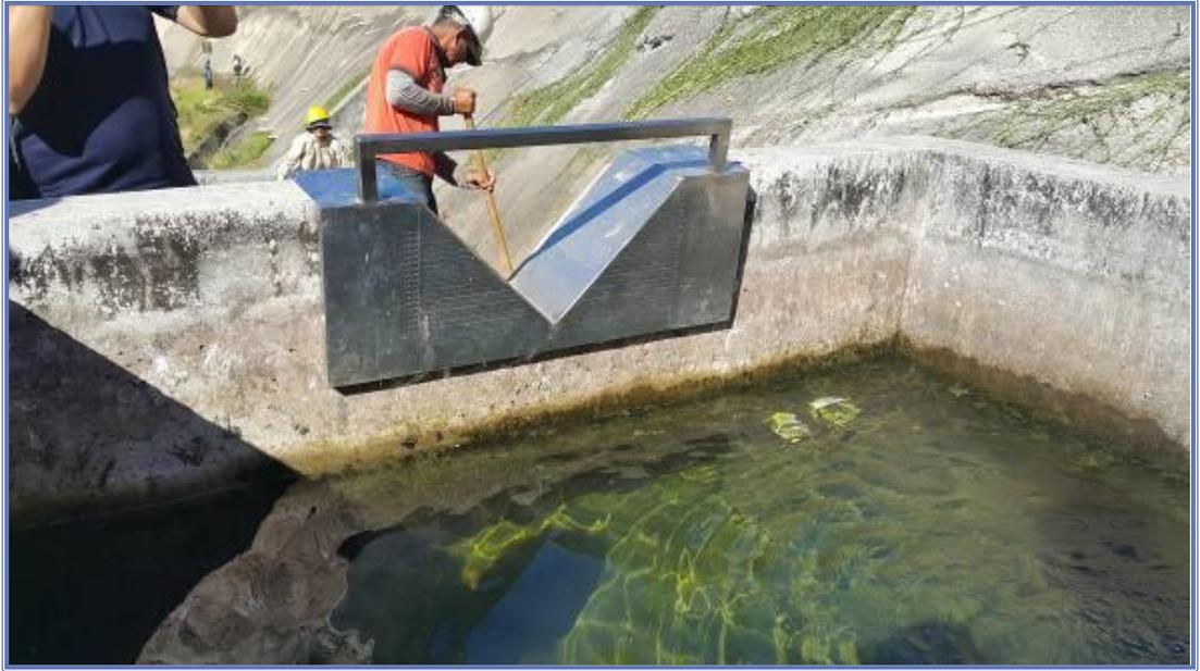
Figura N° 12: Vertederos rectangulares para medición de volumen de agua. Fuente: Alternegy, S.A.
