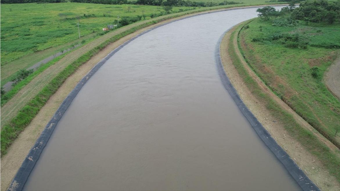
Figura N° 9: Vista de la limpieza y mantenimiento del pasto sobre los diques y canales.
