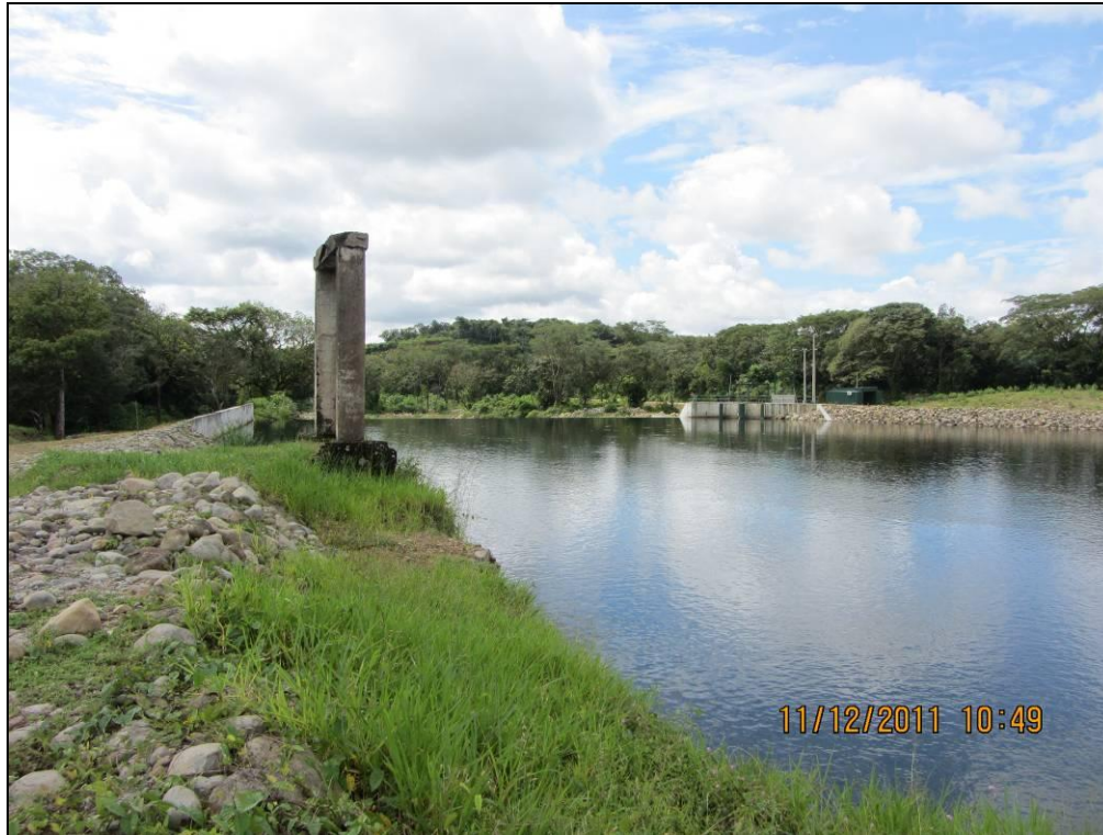
Foto Nº 1 – Vista del Embalse de la Presa Los Planetas I
