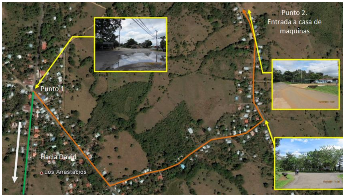
Figura N° 4 – Camino de Acceso Permanente a la Casa de Máquinas
