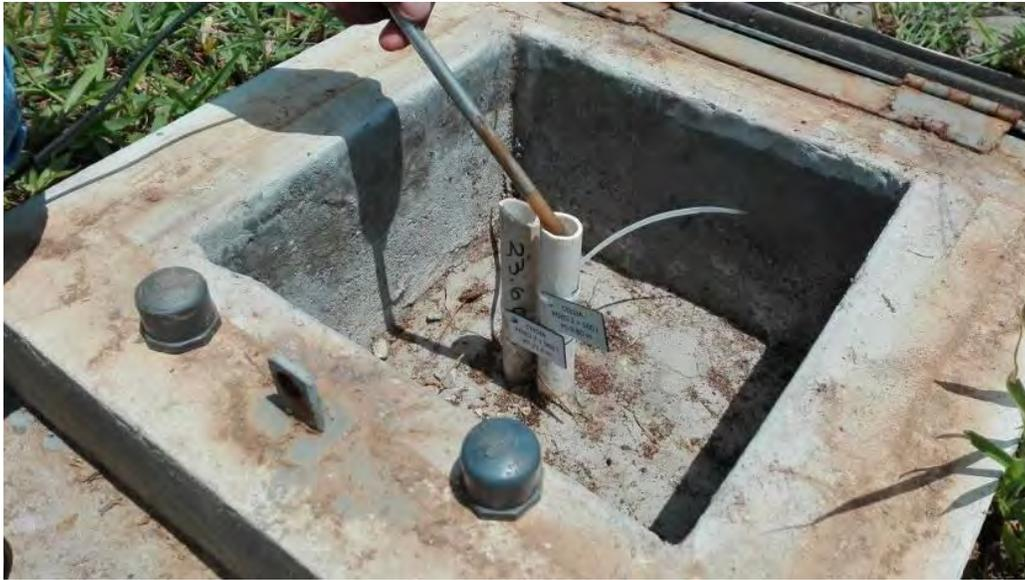
Figura N° 3: –Piezómetro Abierto en los Canales de Aducción de la CH Lorena.
