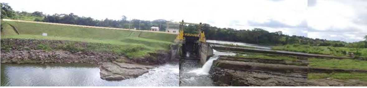
Figura N° 6: Vista hacia aguas abajo por eje de presa
