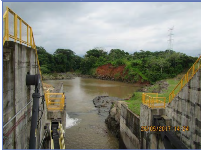
Figura N° 5. Vista Frontal de Vertedero Gualaca
