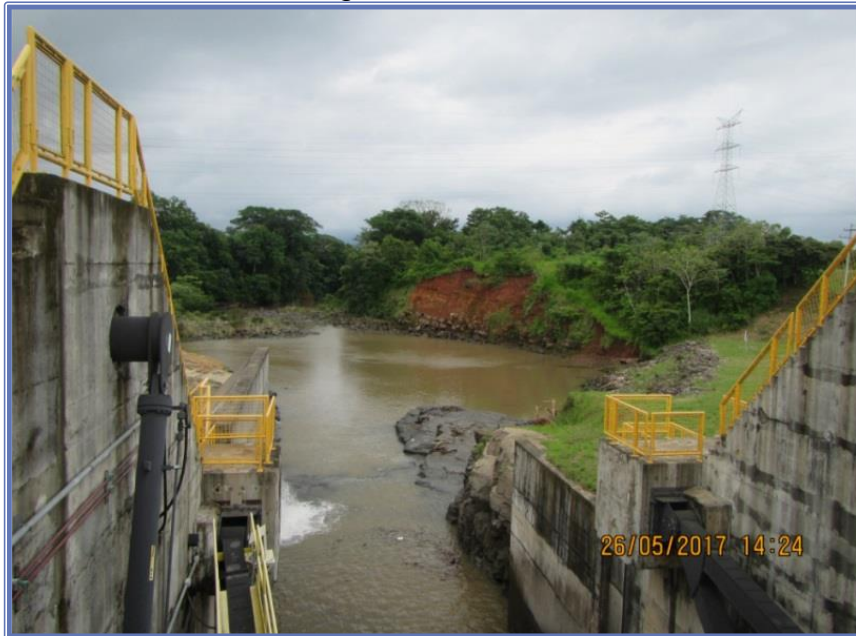
Figura N° 5. Vista Frontal de Vertedero Gualaca
