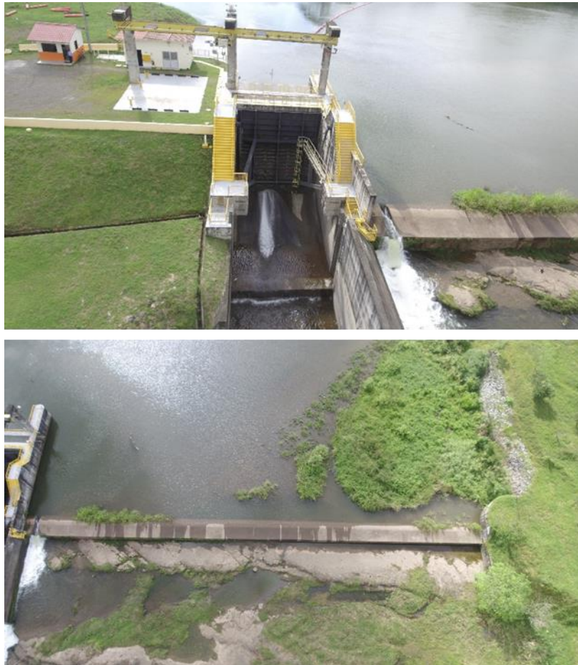
Figura N° 4 Vista de los Vertedero controlado compuerta radial y vertedero libre de la Presa de Gualaca
