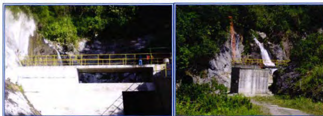
Figura No 5. Fotografías de las estructuras de desvío Presa de Derivación de Pinola. Fuente: ENEL Fortuna, noviembre de 2013.
