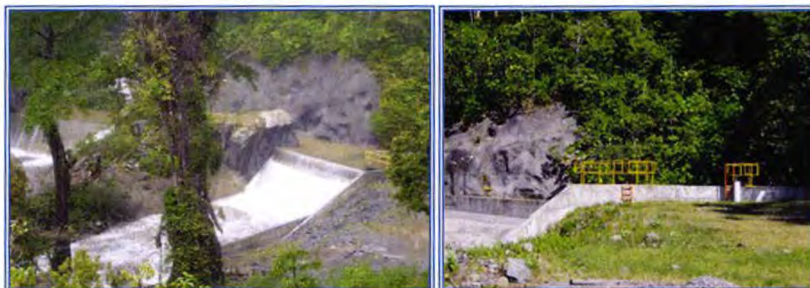
Figura No 4. Fotografías de las estructuras de desvío Presa de Derivación y Presa de Contención Las Huacas. Fuente: ENEL Fortuna, noviembre de 2013.
