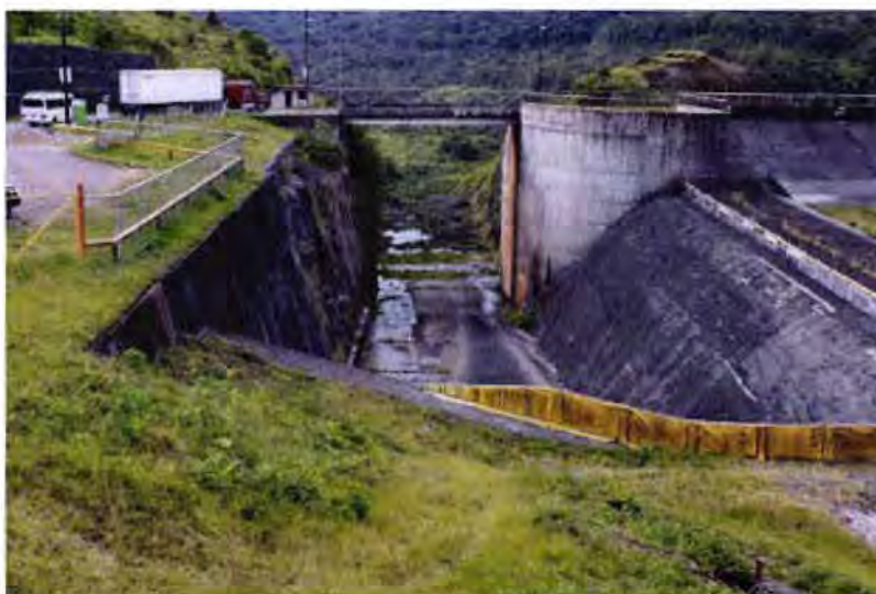
Figura No 15. Vertedero de Fortuna que muestra que es un vertedero sin compuertas o vertedero no controlado. Fuente: Consultor, mayo 2013.
