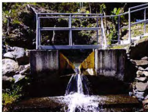
Figura No 10. Vertedero y equipo de aforo para medir filtraciones de la presa. Fuente: Consultor, mayo de 2013.
