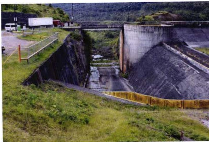
Figura No 15. Vertedero de Fortuna que muestra que es un vertedero sin compuertas o vertedero no controlado.
