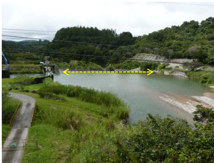
Figura 1. Vista de presa Derivadora sobre el Río Caldera
