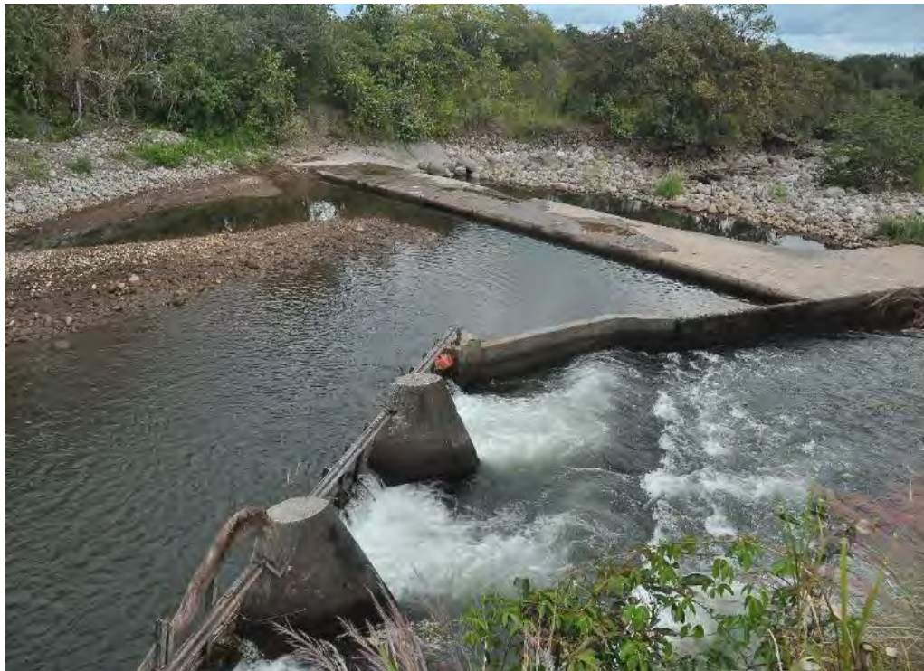
Foto N°1- Condición operativa de la Presa Dolega
