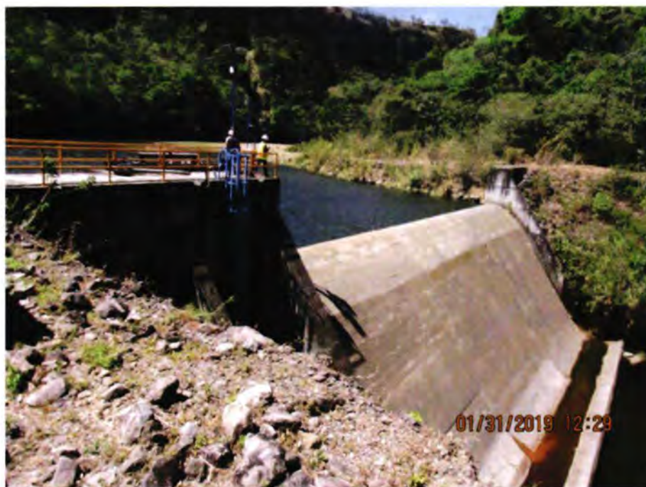
Foto N°1- Condición de la Presa Cochea
