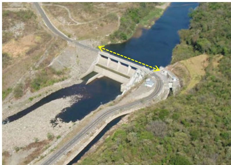
Figura 1 Vista de Presa Chiriquí
