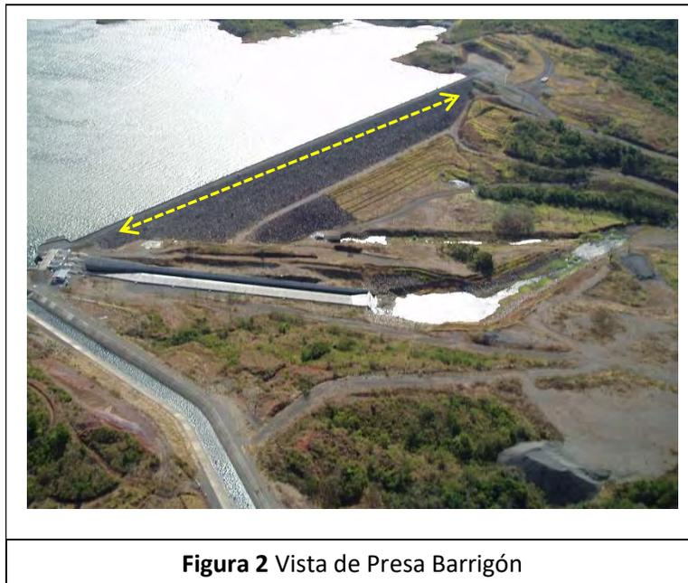
La cresta del vertedero se ubica en la Elevación 222.5 msnm, tiene una altura máxima de 63 m y una longitud de cresta de 810 m. La capacidad de descarga en forma conjunta del vertedero y la descarga de fondo es de 1,200 m<sup>3</sup>/s que corresponde al diseño para el periodo de retorno de inundación de 10,000 años.
