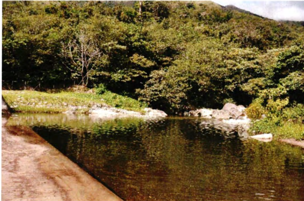
Foto D3 - Presa de Casita de Piedra (Presa 3)
