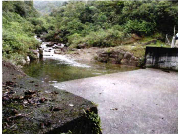
Foto N°2 – Embalse de la Presa Algarrobos 2
