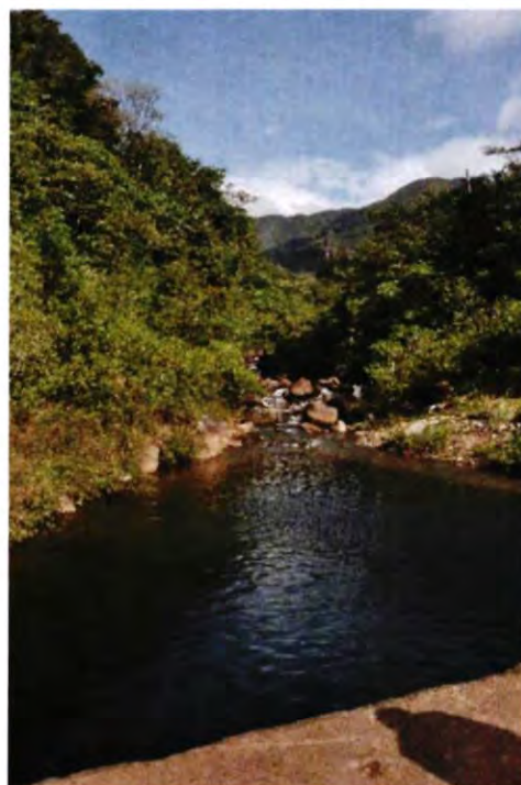
Foto N°1- Condición operativa de la Presa Algarrobos 1
