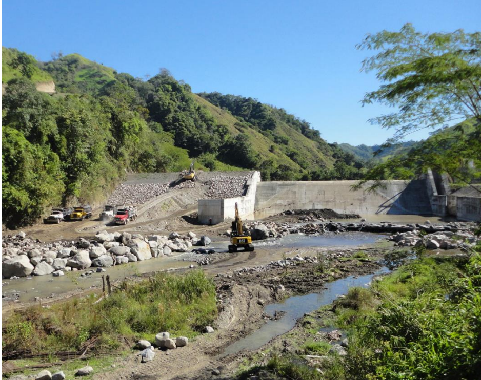
Foto N°1- Condición de la presa Caña Blanca
