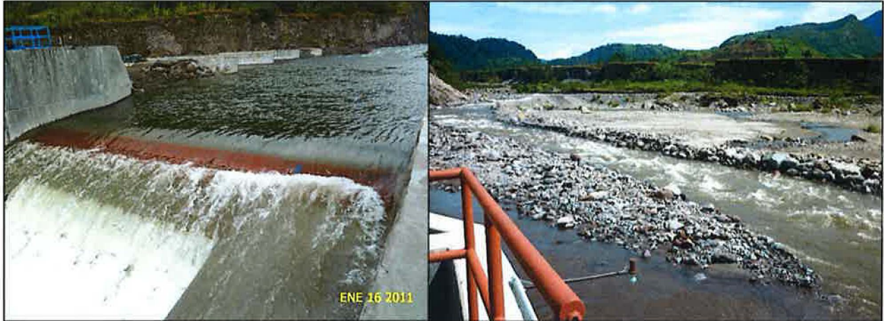
Foto N° 1 – Vista de la Presa y Toma - Paso Ancho
