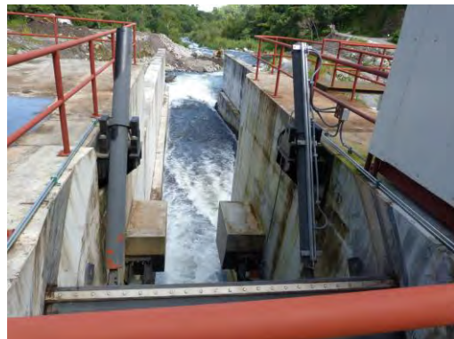
Foto 6. Vistas de una de las compuertas de fondo de la presa Pando
