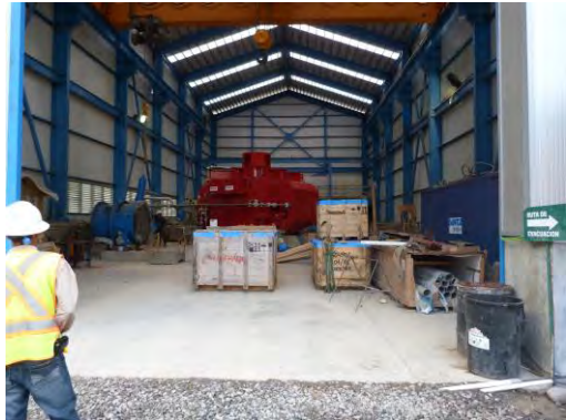
Foto 3. Casa de máquina de la Central Hidroeléctrica Pando
