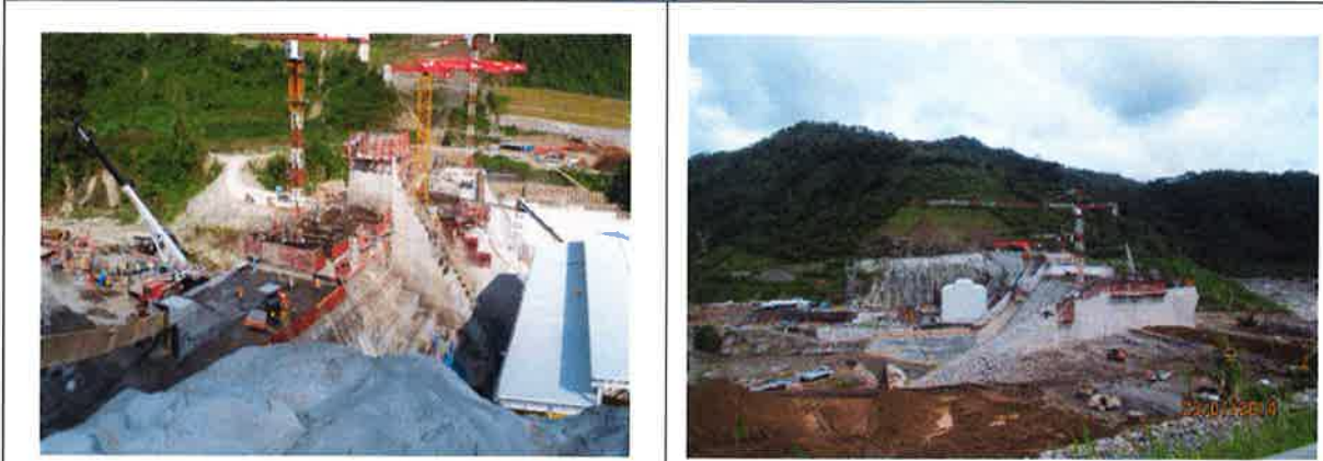
Presa en construcción
