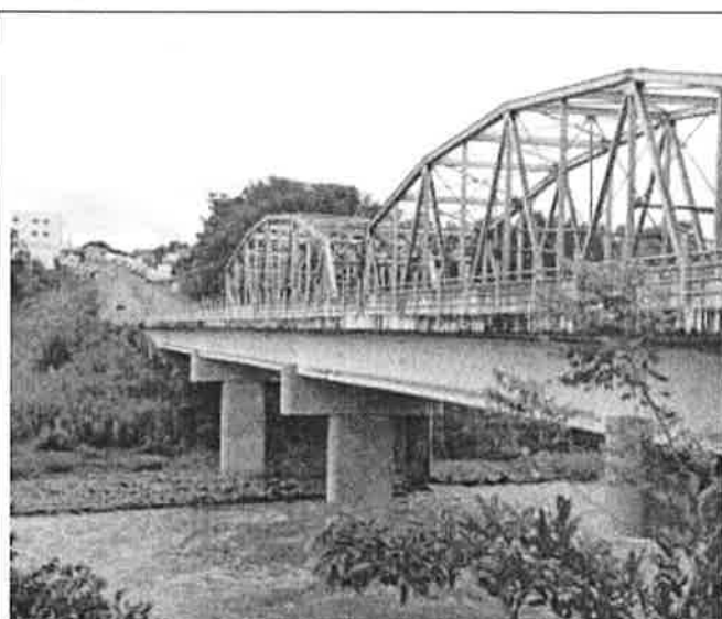
Figura 4. Puente sobre la Panamericana
