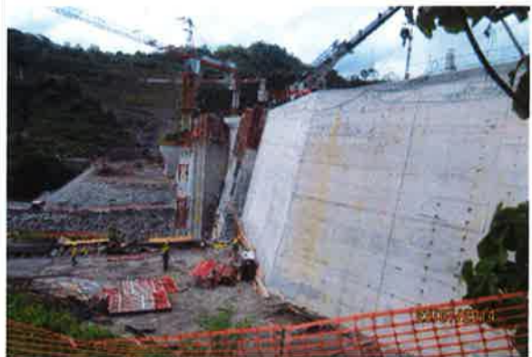
Aguas arriba del proyecto
