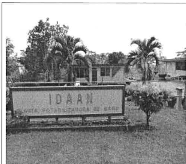
Figura 3. Planta potabilizadora de Barú
