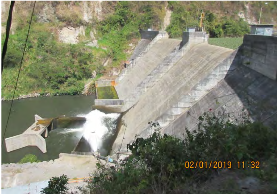
Foto N°1- Condición de la Presa El Alto
