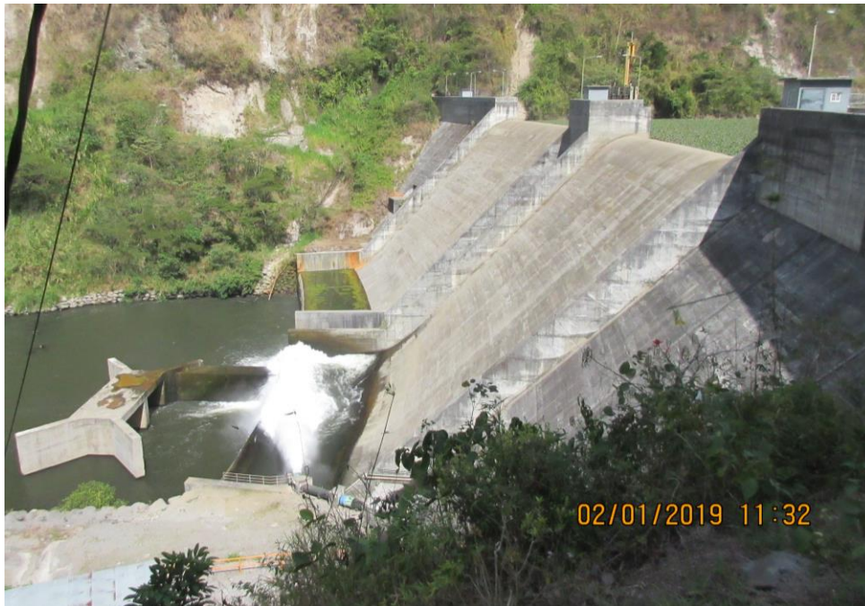
Foto N°1- Condición de la Presa El Alto
