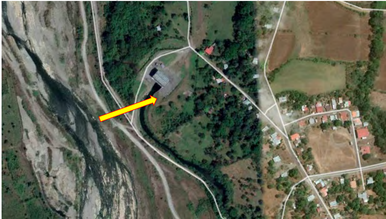
Figura N°5 – Afectación en casa de máquinas
