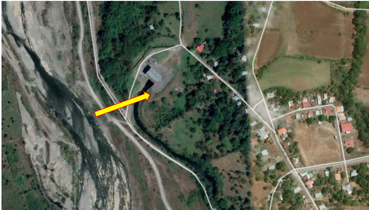
Figura N°5 – Afectación en casa de máquinas
