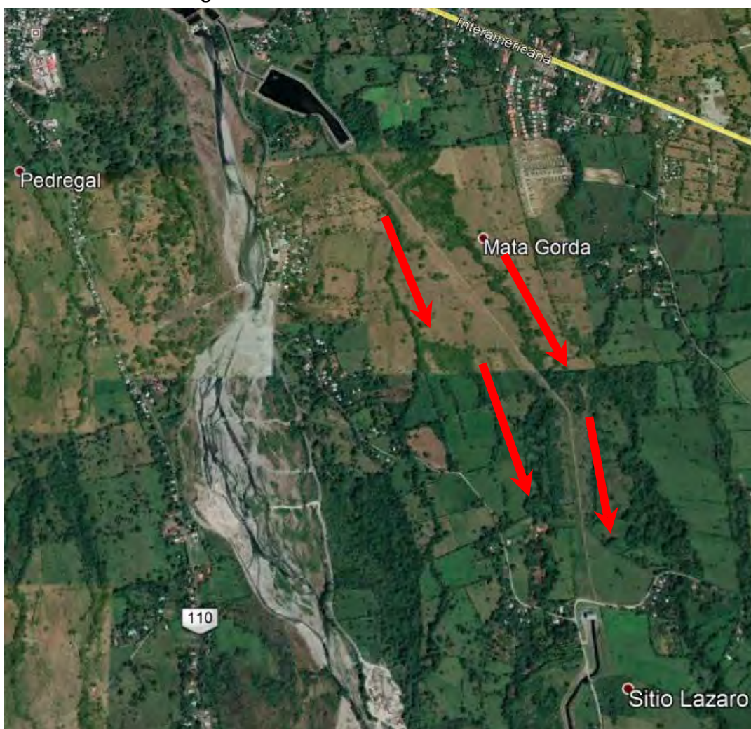
Figura N°7 – Afectación en Tubería de Presión
