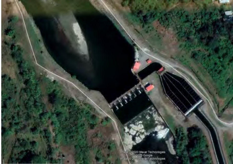
Figura N°4 – Ubicación de la presa de la Central Hidroeléctrica Pedregalito 1
