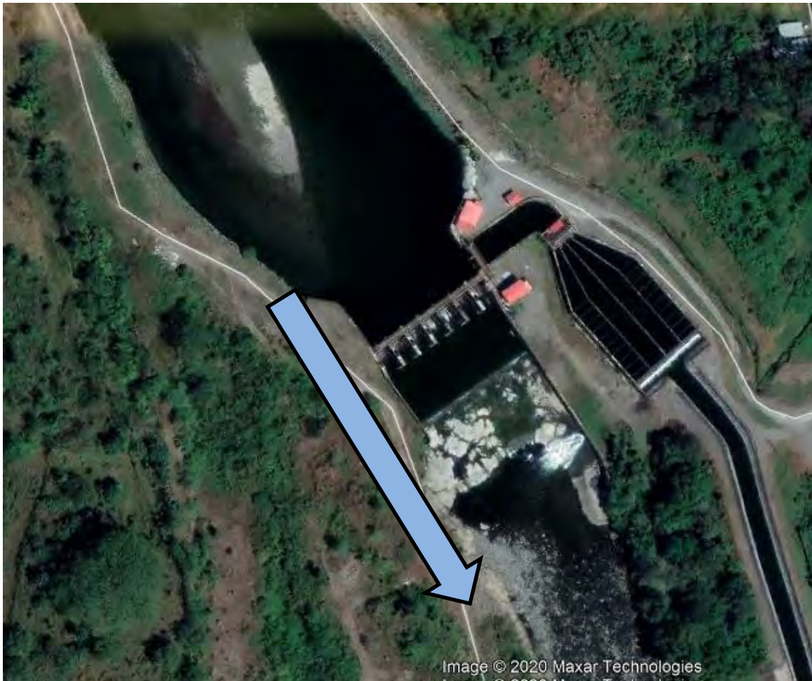
Figura N°5 – Desborde por dique fusible
