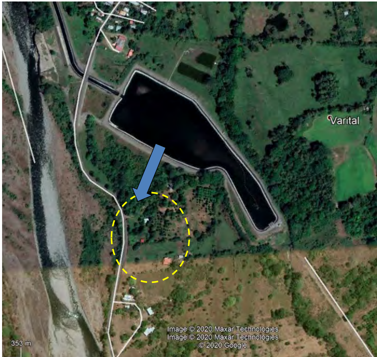
Figura N°6 – Afectación en Cámara de Carga
