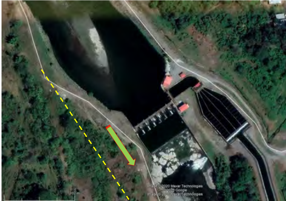
Figura N° D9 – Vista Aérea de la Presa Pedregalito 1
