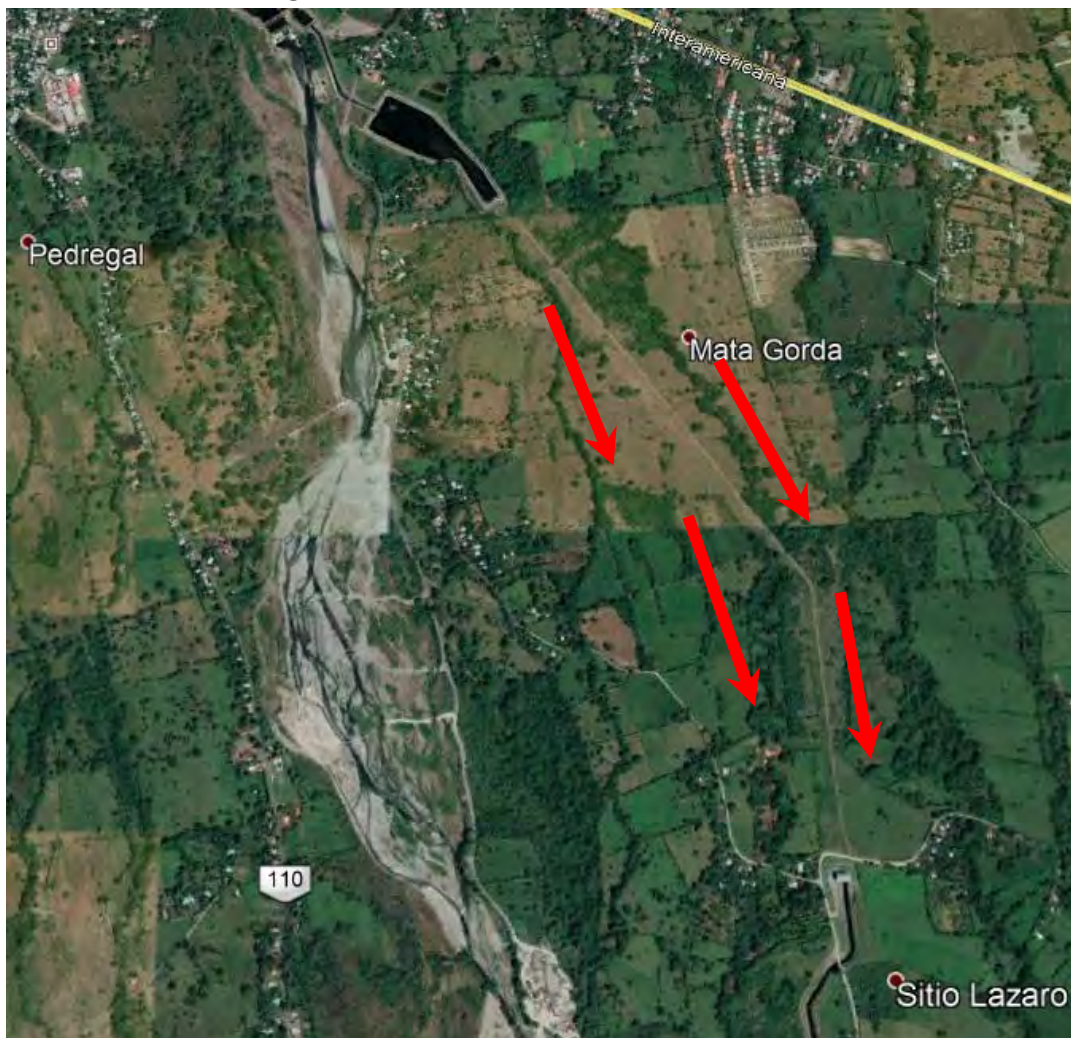
Figura N°7 – Afectación en Tubería de Presión
