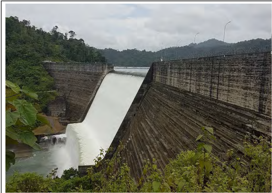
Figura 1. Vista de la Presa Changuinola I
