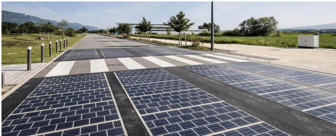
Figura 12: Células solar incrustada en carretera
