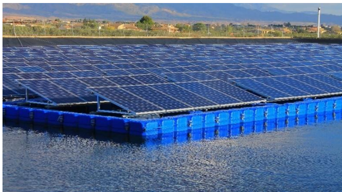
Figura 11: Sistema de paneles fotovoltaicos flotantes
