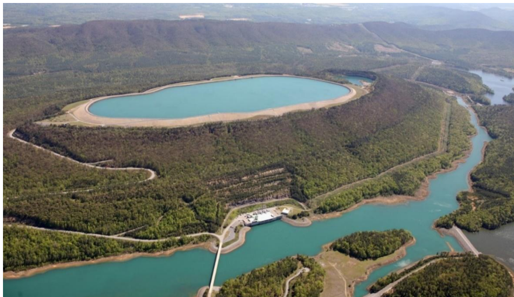
Figura 51: Central Hidroeléctrica con Bombeo de agua dulce Rocky Mountain (1095 MW), ubicada en el estado de Georgia, Estados Unidos.
