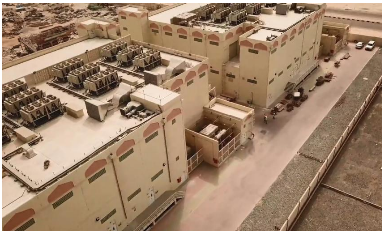
Figura 57: Sistema de Almacenamiento de 20MW ubicado en Abu Dhabi.
