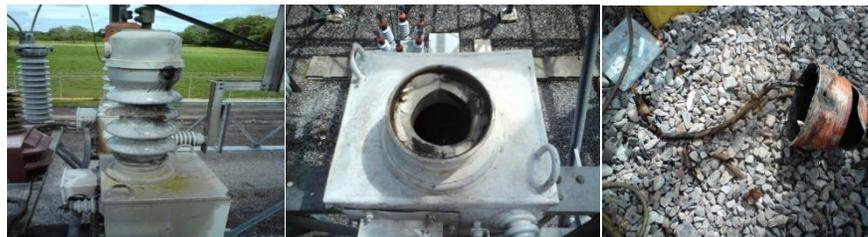
Los transformadores de tensión candidatos a reposición, en el corto plazo, son del tipo capacitivo, en su mayoría sellados, con el núcleo sumergido en aceite; los cuales están próximos a finalizar su periodo de vida útil.
