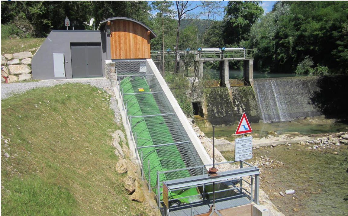
Figura 2. 2: Central hidroeléctrica con turbina tipo tornillo de Arquímedes
