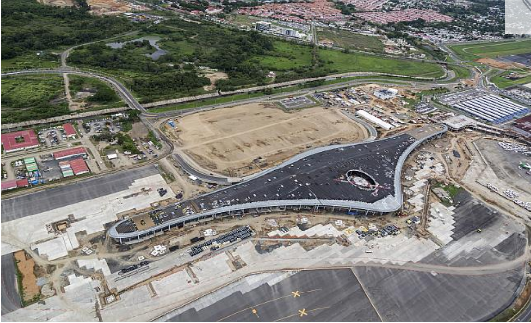
Figura 9. Avance de la Terminal 2. Referencia: (ODEBRECHT, 2019).
