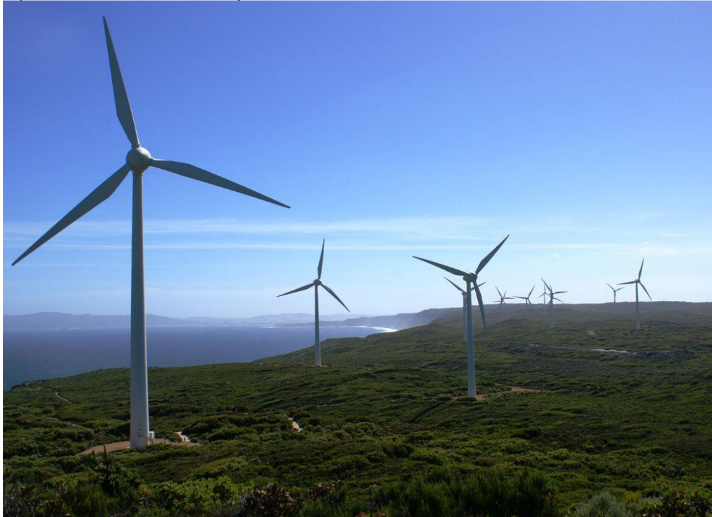
Figura 2. 13: Parque eólico con turbinas de viento de eje horizontal.
