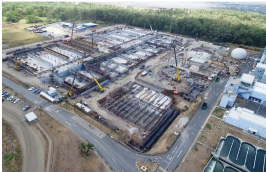
Figura 3. Ampliación de la Planta de Tratamientos de Aguas Residuales.
