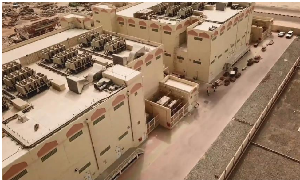
Figura 2. 38: Sistema de Almacenamiento de 20MW ubicado en Abu Dhabi.
