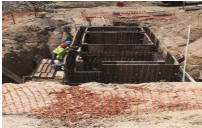
Figura 8. Avance de Planta potabilizadora El Real. Referencia: (IDAAN, 2019).
