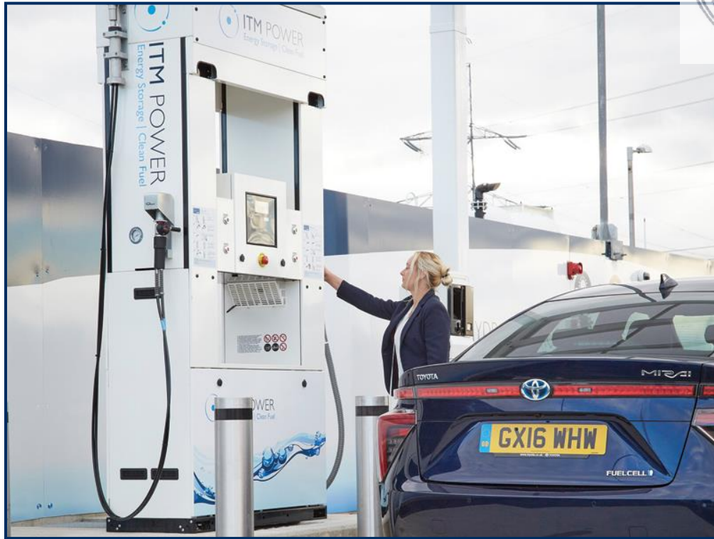
Figura 2. 52: Centro de carga para vehículos con celdas de hidrógeno.
